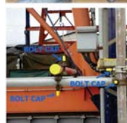
ใส่ cap พลาสติกในจุดคั่นเคบหรือทางเดินสัญจรที่อาจเป็นจุดชน เอี้ยวหรือกระแทก
