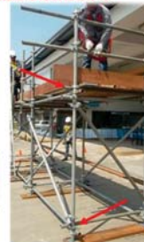
แท่นปัดลอคส้านั่งร้านกับคานและคานหลักใช้แท่นปัดลอคแบบ Double Coupler เท่านั้นและแท่นปัดลอคหาง
